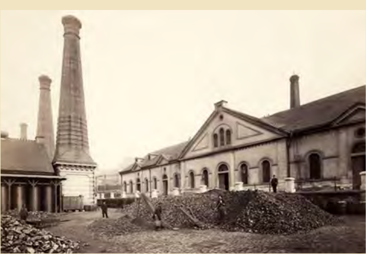
Žižkovská plynárna. Poč. 20. stol. (reprodukt z knihy: Antl – Vík, Křížkova žižkovská elektrárna. Praha 2024)
