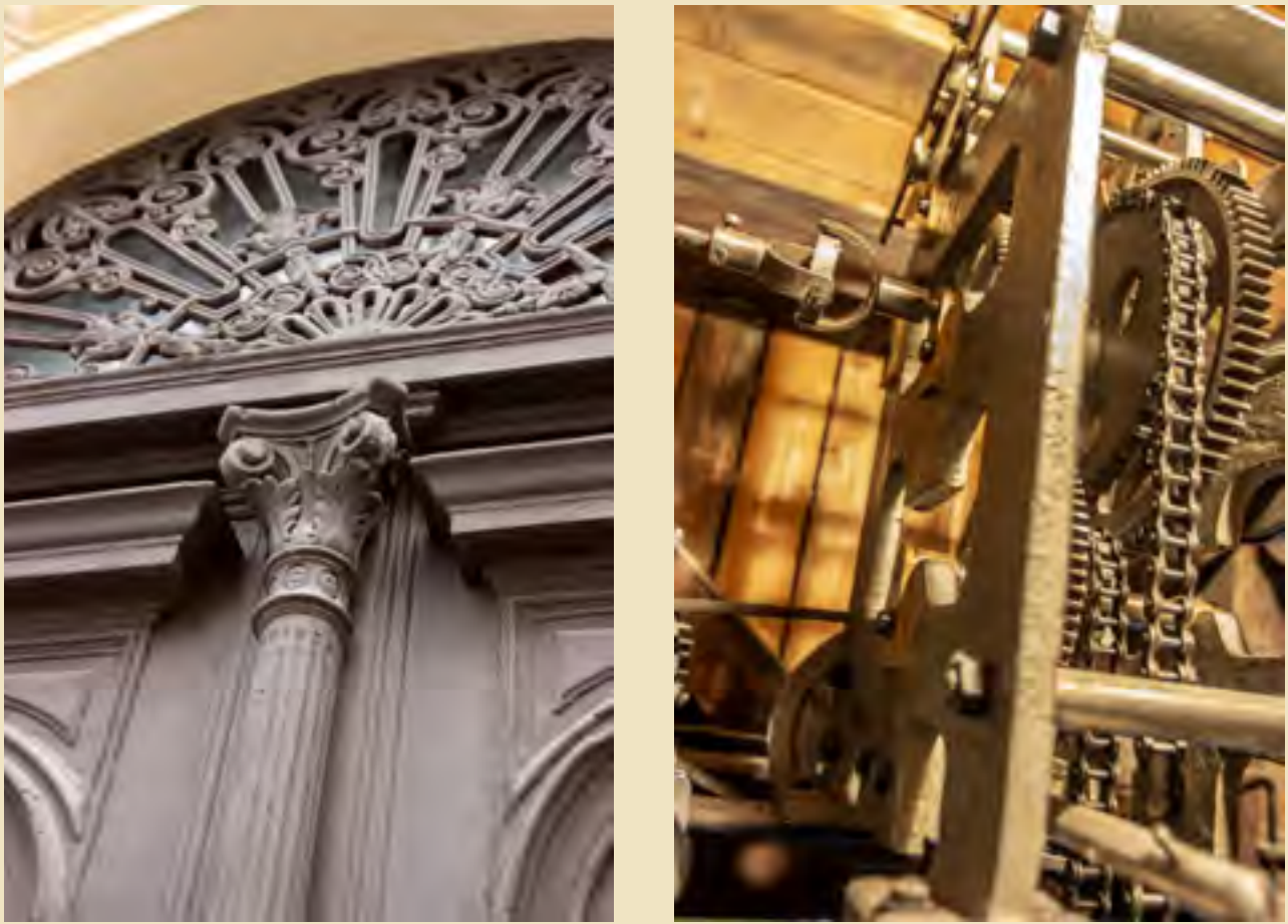
Výstavní budova bývalé záložny čp. 100. Portál budovy a hodinový stroj ve věžičce Roku 1880 dům koupila obec a umístila tam městský úřad i některé školní třídy.
